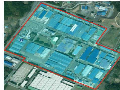
| 세종사업장 소음 측정 부지경계선
